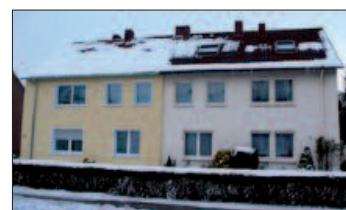
Das Dach der linken Doppelhaushälfte ist bereits gedämmt. Die Schneedecke schmilzt langsamer als beim Nachbarn.
