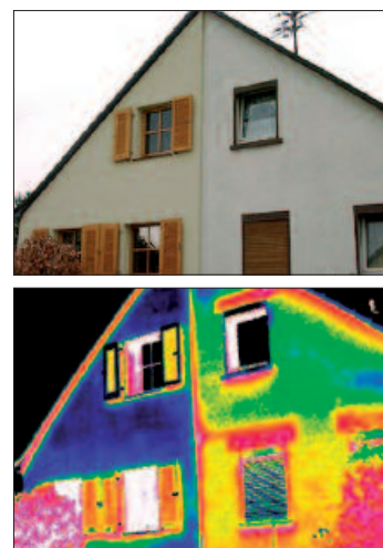
Im Vergleich: Die gedämmte Fassade (links) verzeichnet weniger Wärmeverluste als die unsanierte Hälfte.
